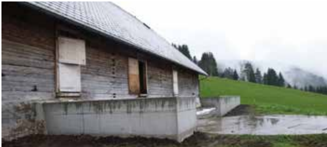
Die fertig erstellte Mauer
